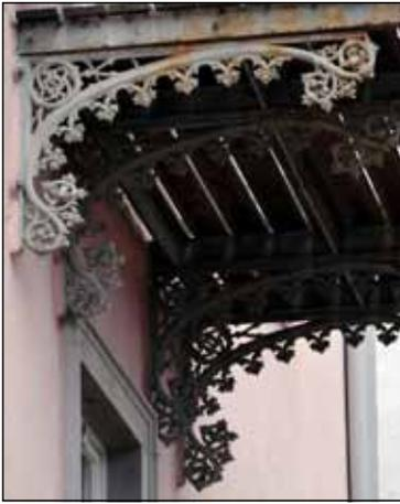
Abb. 32: Gusseiserne Balkonträger an der Südostseite.
