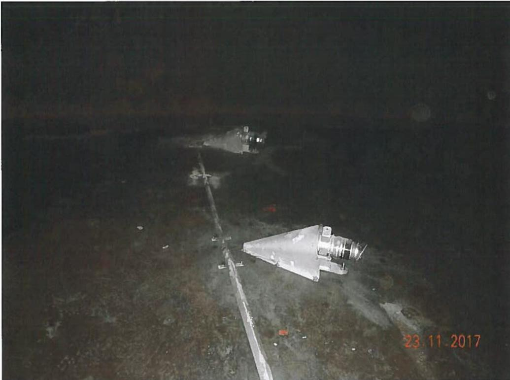
**Abbildung 8: Eltville, RÜB Hattenheim, Einbau von Wirbeljets zur Beckenreinigung**
