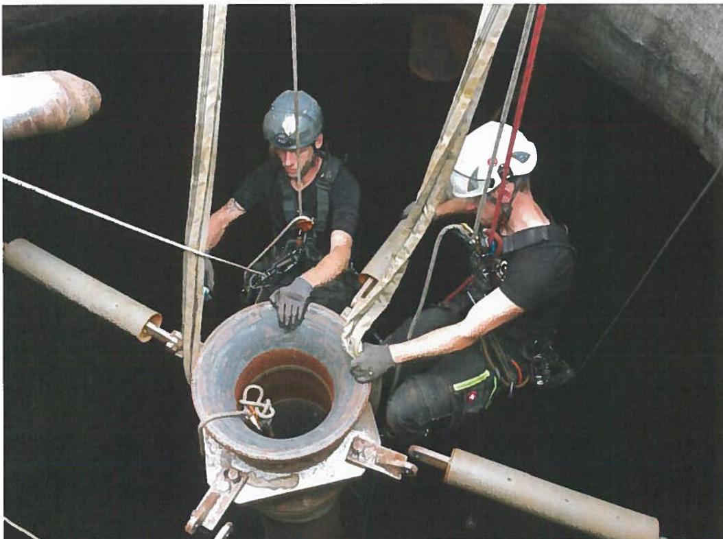
**Abbildung 5: KA Grünau, Sanierung Faulbehälter, Ausbau Schlammischer**
