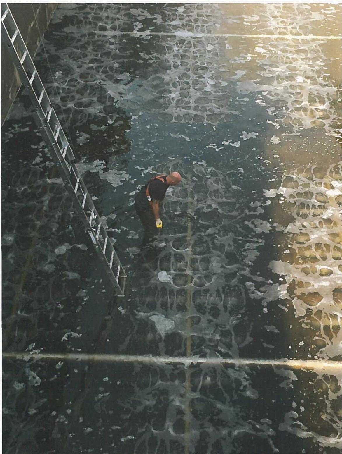
**Abbildung 3: KA Grünau, Austausch Belüftung Belebungsbecken Nr. 2**
