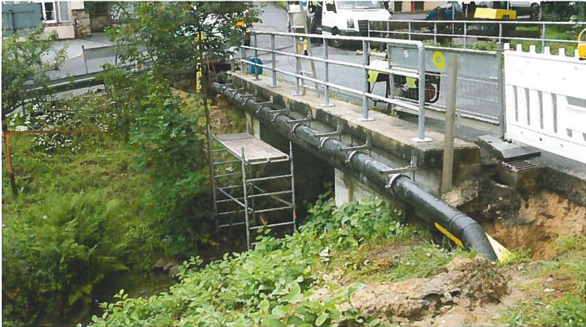
**Abbildung 7: Schlangenbad - Neubau Versorgungsleitung Lochmühle**
