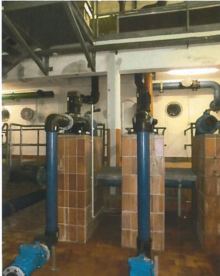
**Abbildung 1: Aufbereitung Eltville - Erneuerung Förderpumpen**
