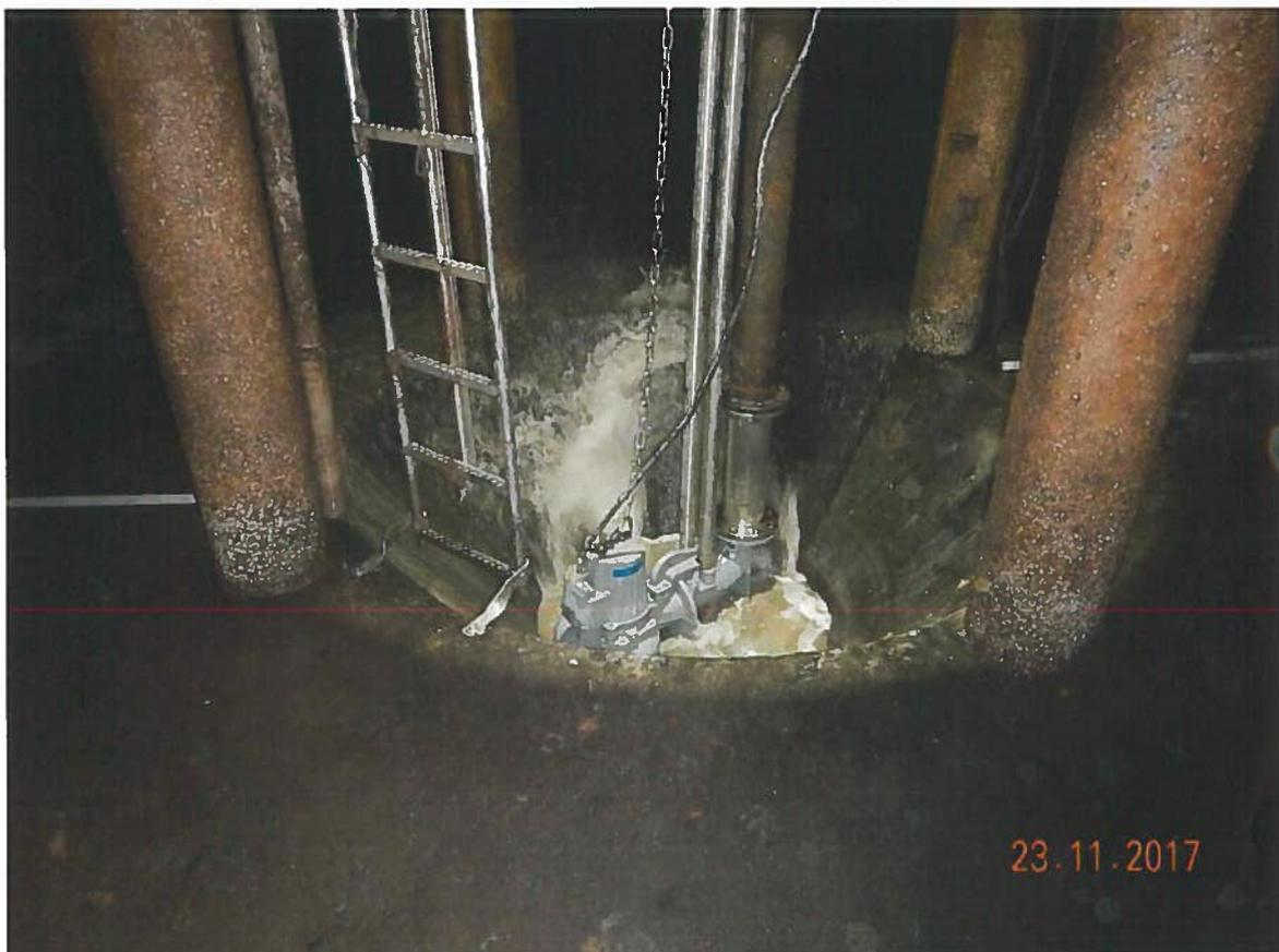
**Abbildung 10: Eltville, RÜB Hattenheim, Einbau neuer Pumpentechnik**
