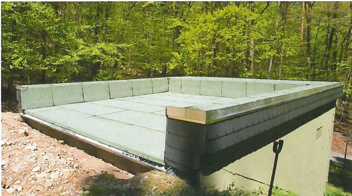
**Abbildung 8: Hochbehälter Rebhang - Dachsanierung**
