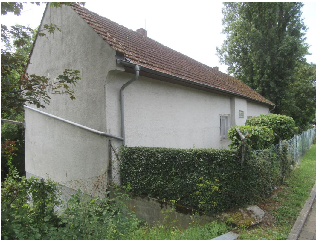
Bild 02: Blick auf die ehemalige Lagerhalle des Wasserwerks auf dem Flurstück 82/10
